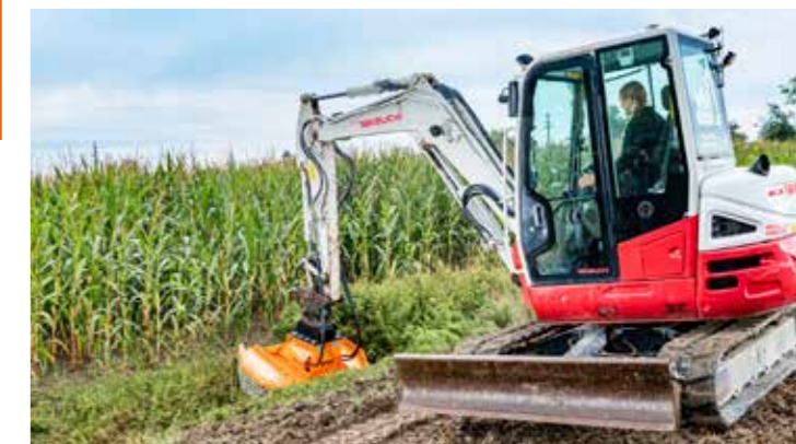
Der Mulcher bei der Böschungspflege.
