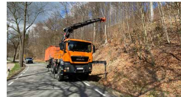
Arbeiten ohne Sperre beider Fahrstreifen möglich.
